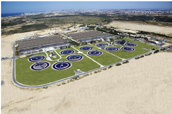
Čistírna odpadních vod Šafdan v centrálním Izraeli
